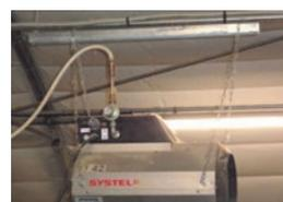
*Système de chauffage abaisssable à l'aide d'une poulie d'échelle*
