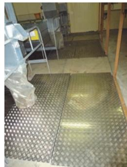
*Protéger la poulie et le moteur du racleur en les recouvrant d'une plaque rigide (acier antidérapant dans l'idéal)*
